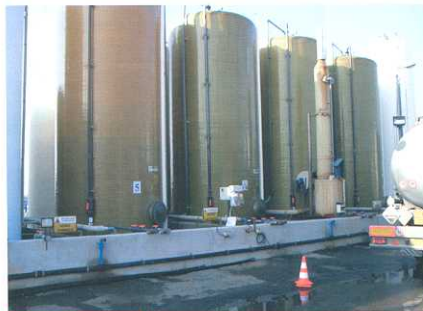
Particolare della piattaforma logistica di Gualtieri (RE)
